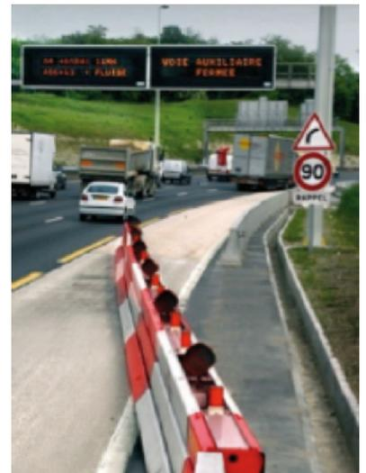
Gestion dynamique des voies : glissière mobile déterminant l'accès à la bande d'arrêt d'urgence sur l'A4/A86. Source : 6t-Bureau de Recherche.
