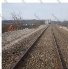
Travaux sur bêche d'ancrage en pied de talus sur zone d'affaissement du 376.215 au 376.265
